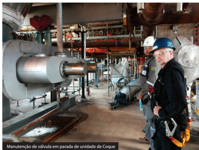
Manutenção de válvula em parada de unidade de Coque
