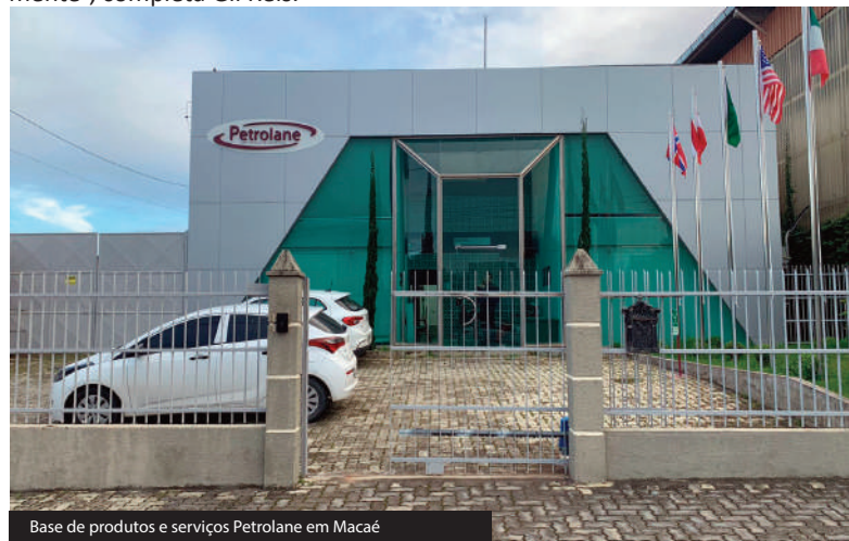
Base de produtos e serviços Petrolane em Macaé
