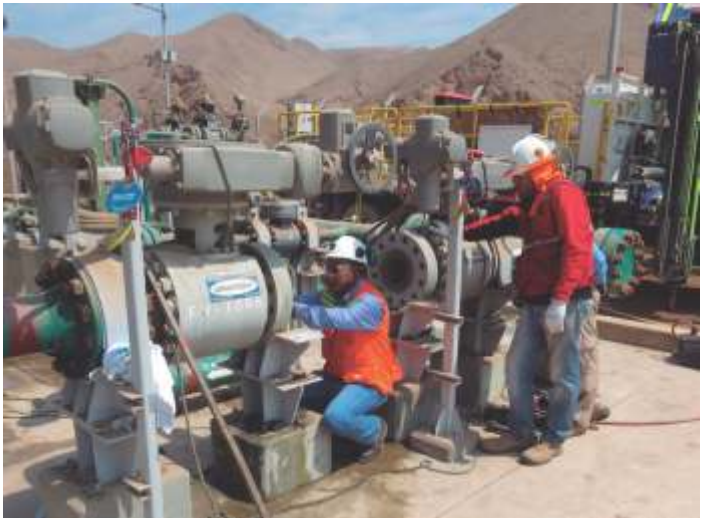
Válvula metal/metal com vazamento zero para minerodutos
