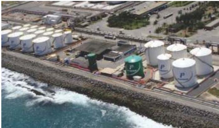
Vista aérea da Pandenor no Porto de Suape-PE
