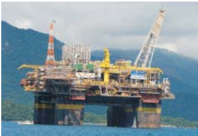
Plataforma P-51 em teste de inclinação na Baía de Ilha Grande
